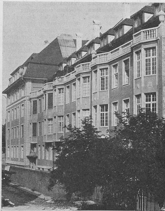
Abb. 7. Nordwest-Fassade der Häuser am Pelikanweg.
