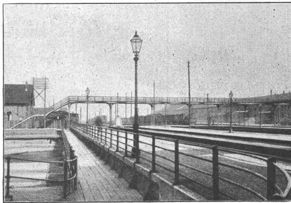
Passerelle Hauptbahnhof Zürich. Eisengewicht 28 Tonnen.
