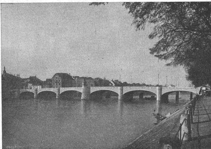
Mittlere Rheinbrücke in Basel, 200 m lang und 18 m Fahrbahnbreite. (Verkleidung sämtlicher Flächen in Gotthardgranit.)
