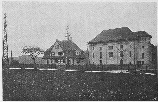
Abb. 69. Transformatoren- und Schalthaus Maulburg, erbaut 1912. Links daneben Wärterwohnhaus.
