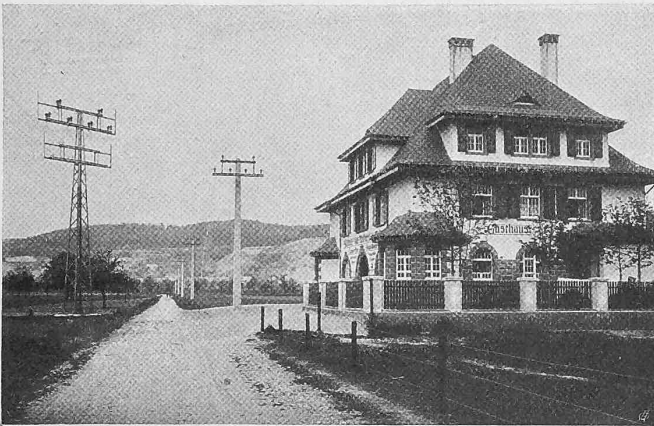
Abb. 72. Abgehende 45 000 Volt-Leitungen beim Kraftwerk Wyhlen. Rechts Eisenbetonmasten der Leitung nach Lörrach, links Gittermast der Strecke nach Schusterinsel.
