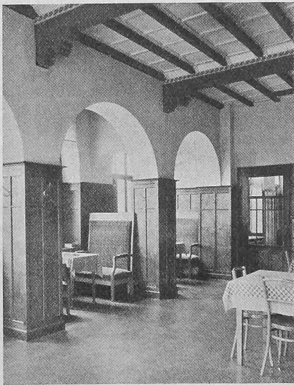
Abb. 10. Restaurant im Erdgeschoss.
