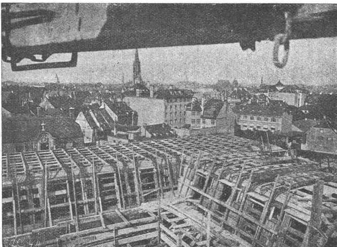
Neubau Lebensversicherungsgesellschaft „Bâloise“, Basel. Eisenbeton „System Züblin“: ca. 12000 qm Decken- und Dachkonstruktionen.
