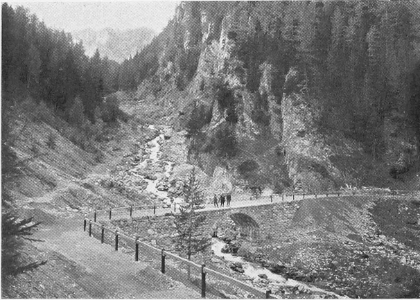
Abb. 13. Brücke im Val Sampuoir (Km. 13,4).
