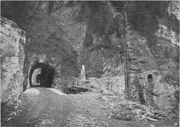
Abb. 9. Im Val da Schais (Km. 8 bis 8,4).
