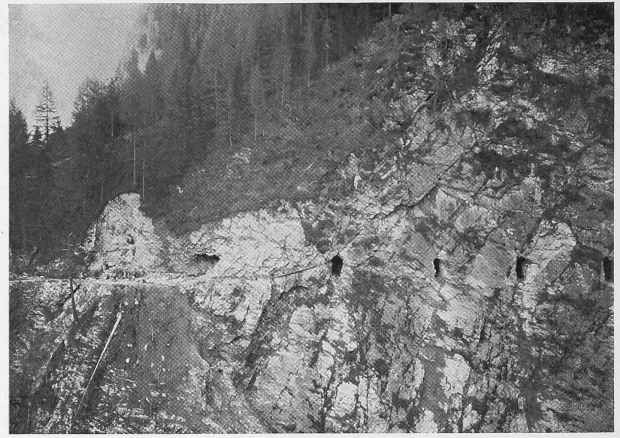
Abb. 12. Fernertobel-Tunnel mit Fenstern, 238 m lang.
