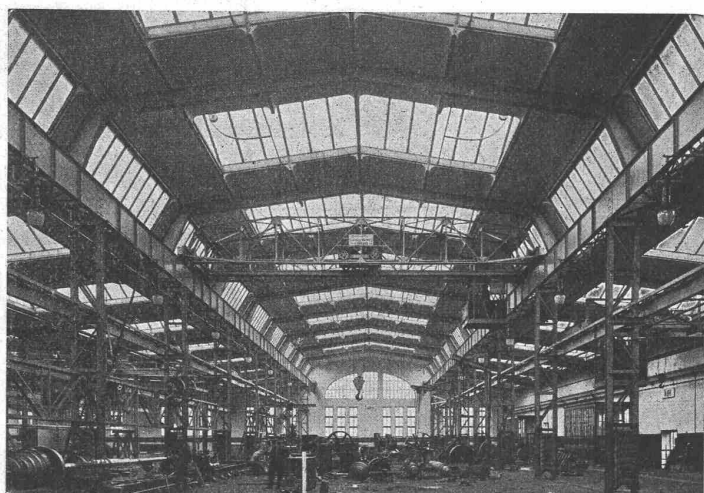
Werkstätten Eisenwerk Wülfel bei Hannover.
