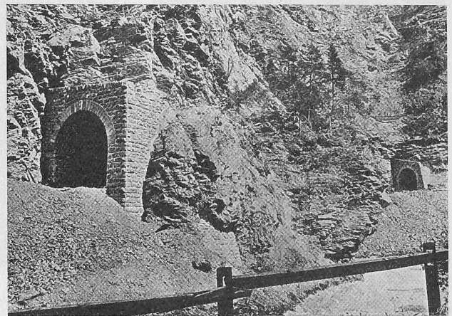
Abb. 2. Portale zum I. und II. Sossal-Tunnel (31. V. 13).
