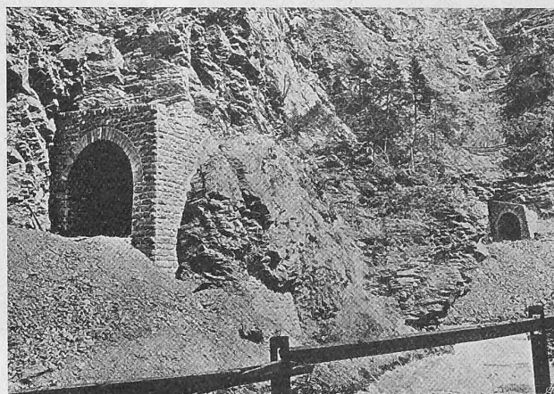
Abb. 2. Portale zum I. und II. Sassal-Tunnel (31. V. 13).
