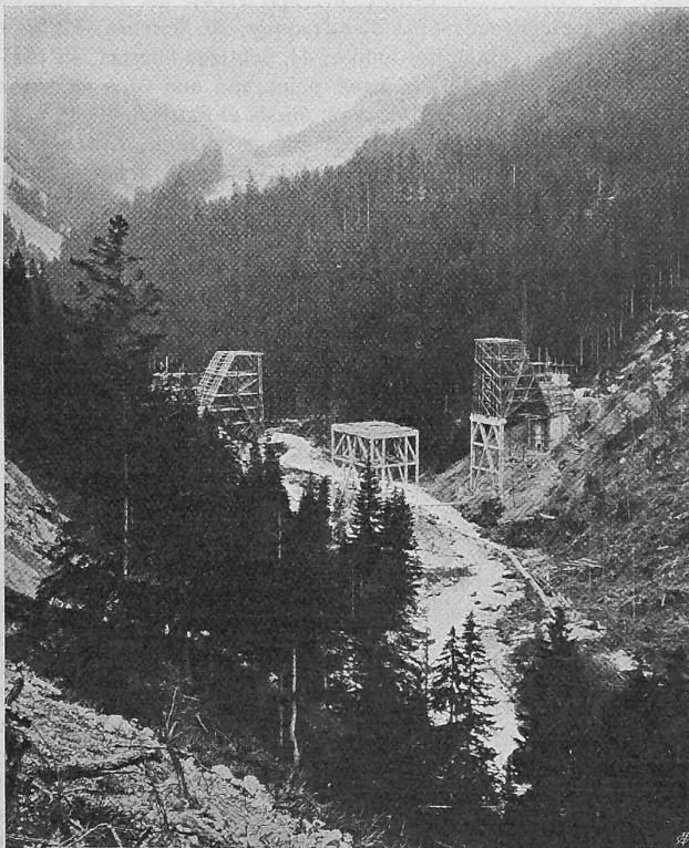
Abb. 19. Eisenbeton-Mittelpfeiler und -Seitenjoche mit teilweise aufgesetztem Holzgerüst zum Langwieser-Viadukt (6. VII. 13).
