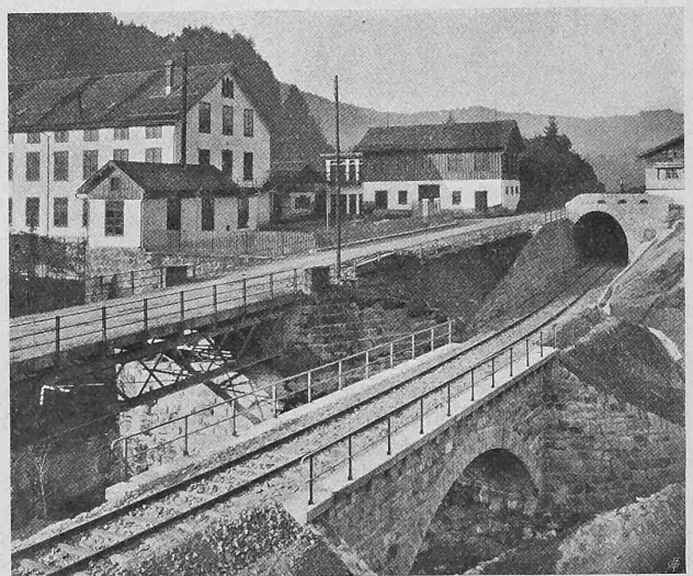
Abb. 5. Brücke über den Lütisbach und Trempel-Tunnel.
