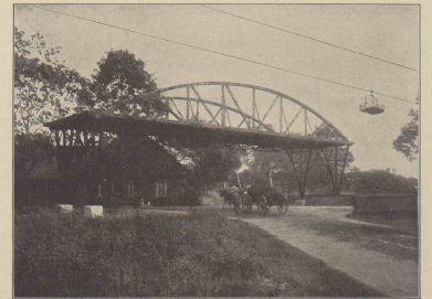
10. Wegebrücke. Spannweiten 20–40 m
