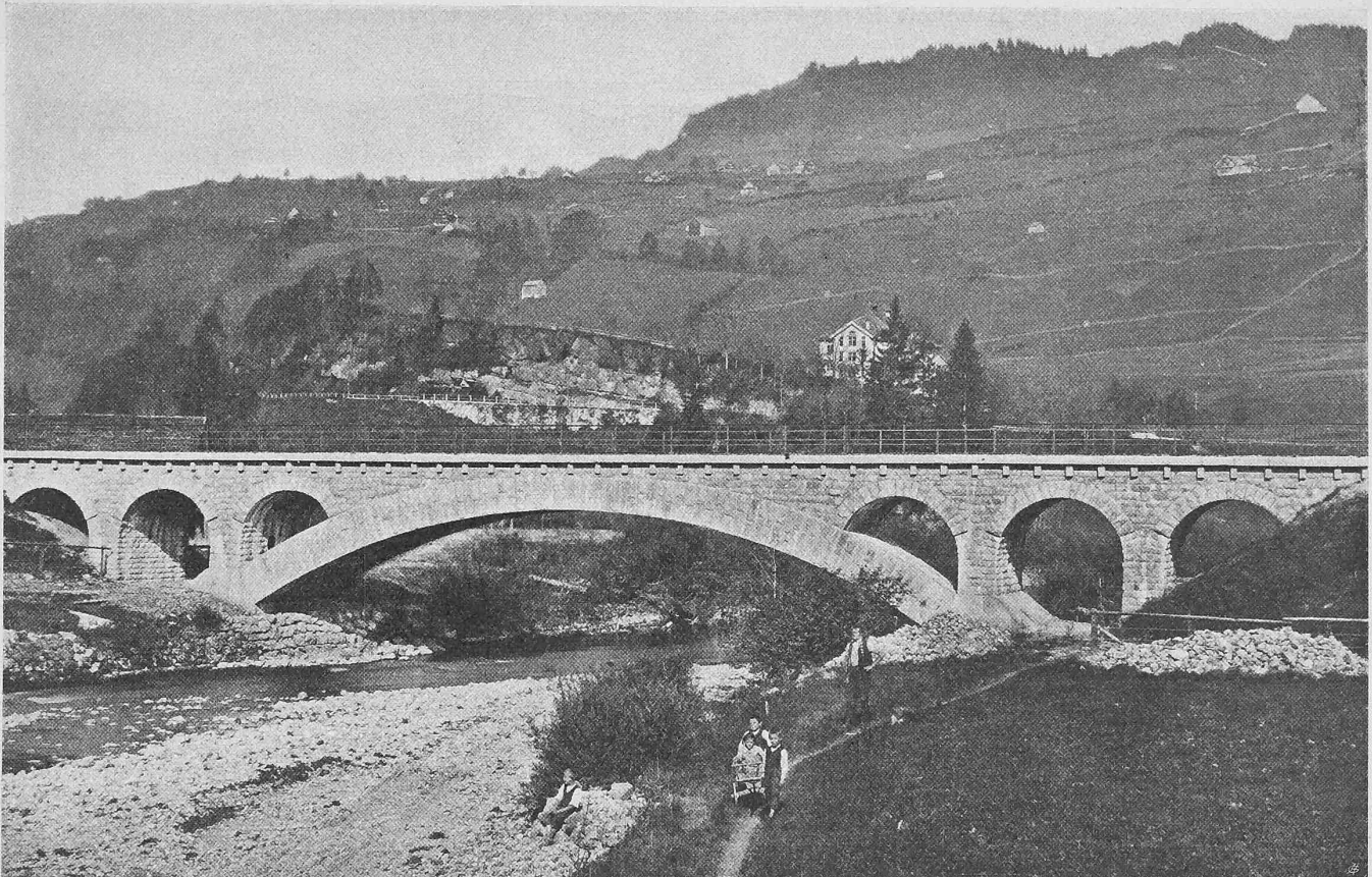
Abb. 19. Steinere Thurbrücke bei Km. 6,650 von 24,82 m Lichtweite. Ansicht von Süden, vom rechten Ufer.
