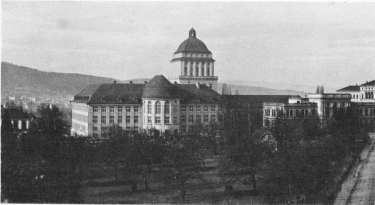
Abb. 3. Gesamtbild aus Osten, vom Eckhaus Plattenstrasse-Gloriastrasse.
