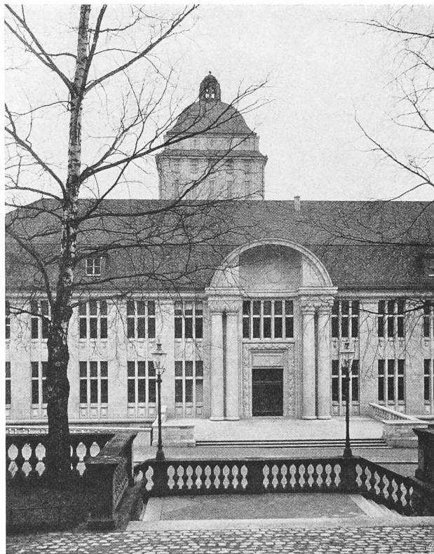
Ansicht von der Nordecke und Haupteingang an der Nordwestfront
