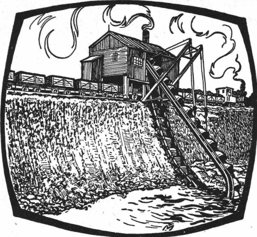
3 Löffelbagger } zur Zeit in der Schweiz 2 Eimerkettenbagger } im Betrieb.
