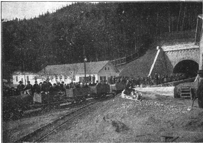
Südportal des Hauenstein-Basis-Tunnels.
