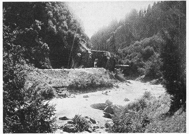
Abb. 5. Tunnel beim Pitascher-Steg.
