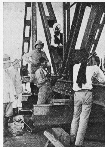
Abb. 5. Pneumatische Nietung.
