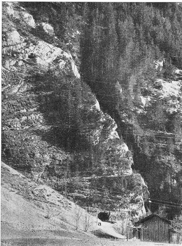
Abb. 1. Ansicht des untern (a) und des obern (b) Stollenzugangs zum Bergaufzug am Trümmelbach-Fall.
