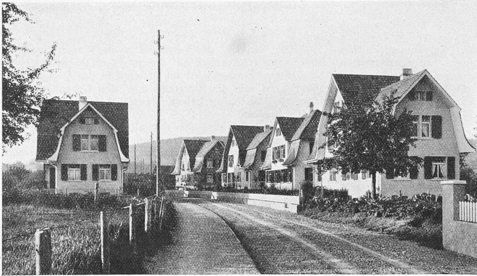
Abb. 9. Blick in die Heimstrasse der Eisenbahner-Kolonie Frauenfeld aus der Wannefeldstrasse, von Norden.
