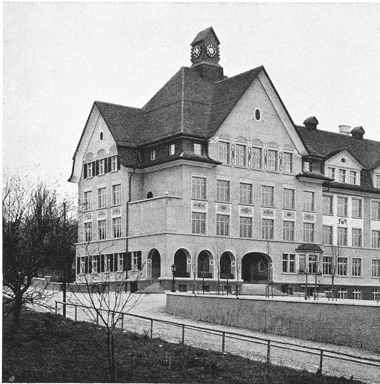
Südliche Ecke mit Haupteingang, Haustüre und Zimmertüre
