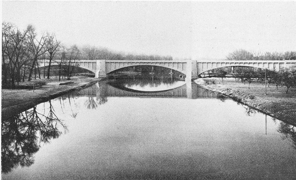
Abb. 2. Ansicht der neuen Eisenbahnbrücke über den Neckar bei Cannstatt, von der König Karls-Brücke aus.
