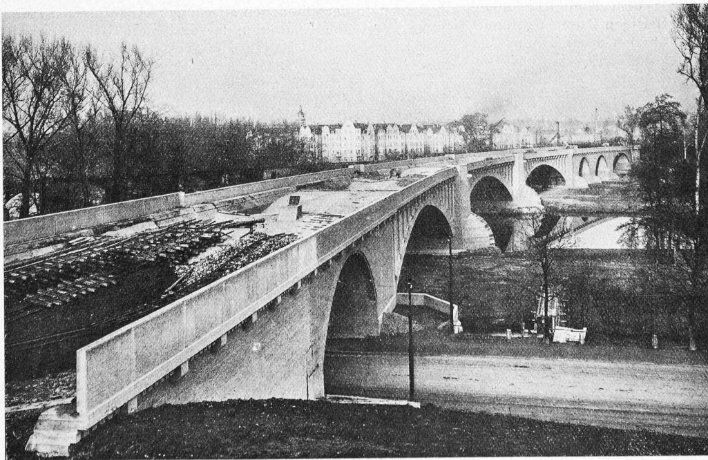
Abb. 3. Ansicht der neuen Neckarbrücke von oberhalb der Stuttgarter Strasse aus (Aufnahme 28. II. 1914).
