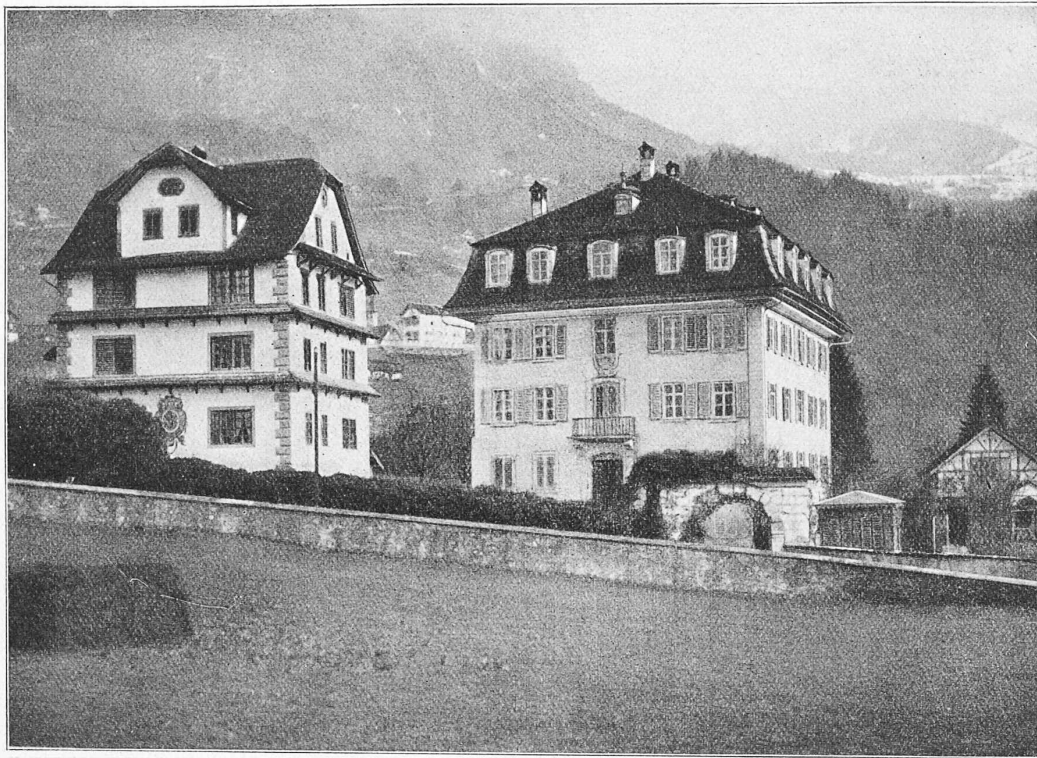
Ansicht der beiden Häuser, des Wohnhauses und des sog. „Steinstöckli“ von Westen. Die Malereien am Nebengebäude datieren aus neuerer Zeit.
