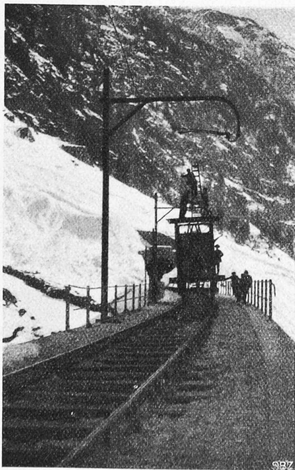
Abb. 36. Drahtziehen bei Goppenstein.
