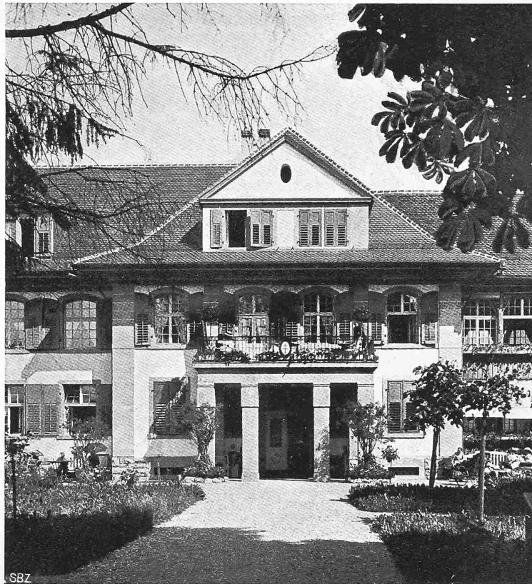
HAUPTTEINGANG DES ERWEITERUNGSBAUES DARUNTER MODELLE FÜR BILDHAUERISCHEN SCHMUCK DER VORHALLEN - PFEILER
