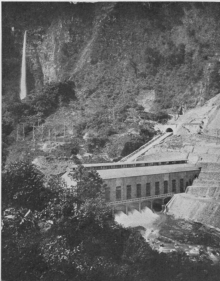
Abb. 5. Kraftwerk «Salto Grande» am Necaxafluss.
