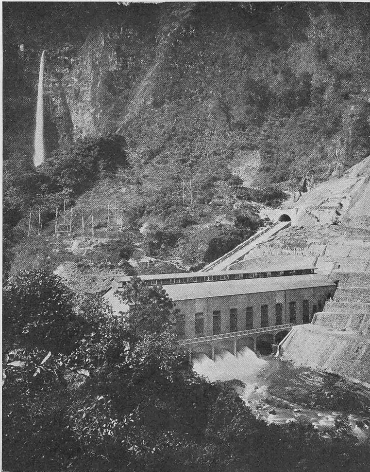
Abb. 5. Kraftwerk «Salto Grande» am Necaxafluss.
