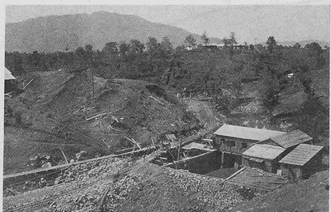
Abb. 9. Reservoir und erstes Pumpenhaus am untern Dammfuss.
