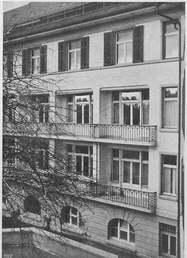
Abb. 10. Balkone der Krankenzimmer an der Südost-Front.
