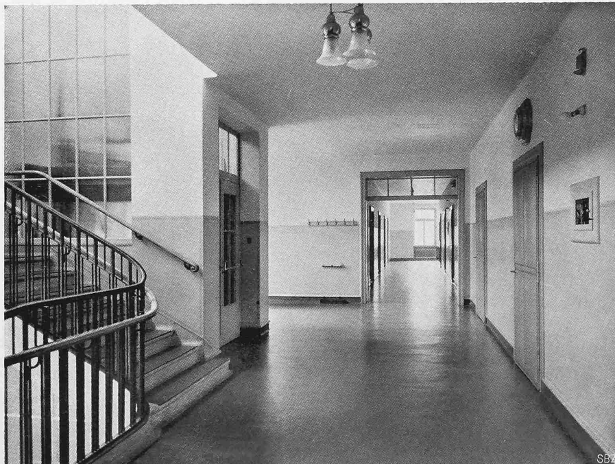
DER NEUBAU DES SCHWESTERNHAUSES VOM ROTEN KREUZ IN ZÜRICH
