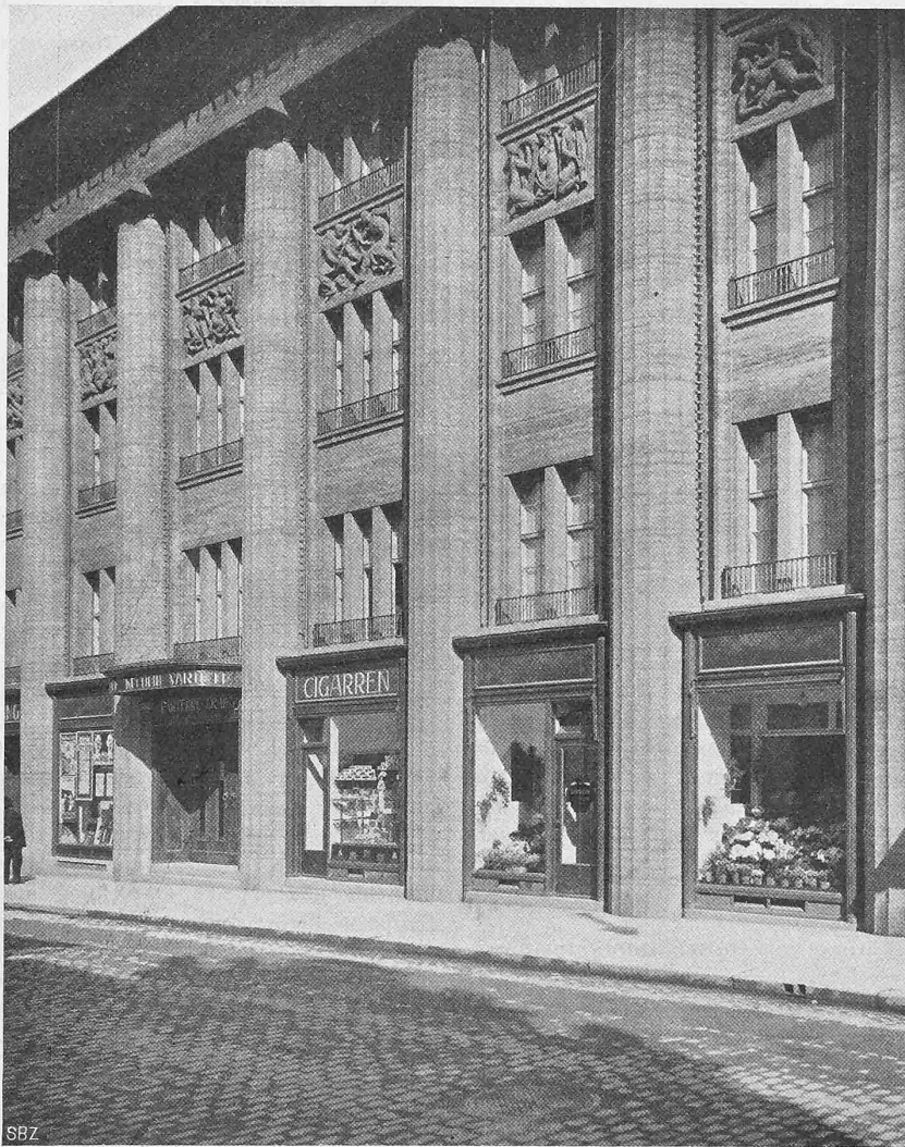
Abb. 7. Detail der Hauptfassade, von Prof. Läger, Karlsruhe.
