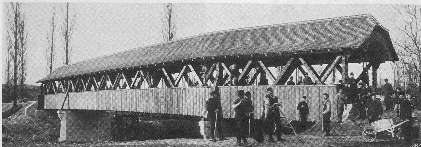
Abb. 1. Ansicht der neuen Birsbrücke bei Münchenstein vom rechten, östlichen Ufer der Birs aus.
