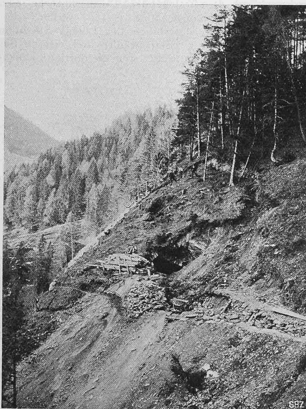
Abb. 2. Nesslaries-Tunnel-Einsturz (6. I. 1913).
