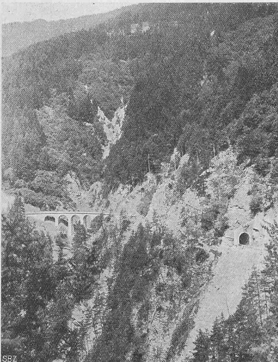
Abb. 24. Schmalztobel-Viadukt und Gitzistein-Tunnel.
