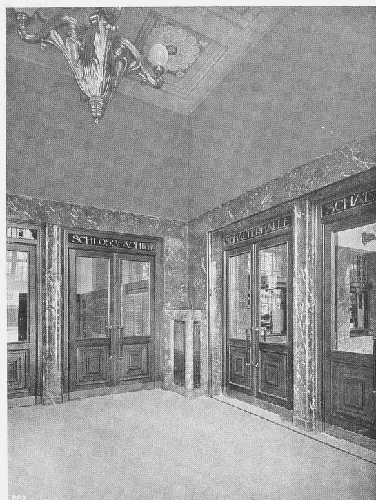
WINDFANG AM NÖRDLICHEN HAUPTINGANG
