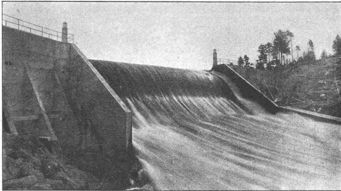
Selbsttätiges Ueberfallwehr Osfaldet für Aamot kommunale Elektricitätsverk (Norwegen)
