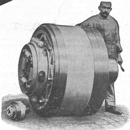
Bann Kupplung Nr. 12 für 600 PS geliefert in eine Zementfabrik.
