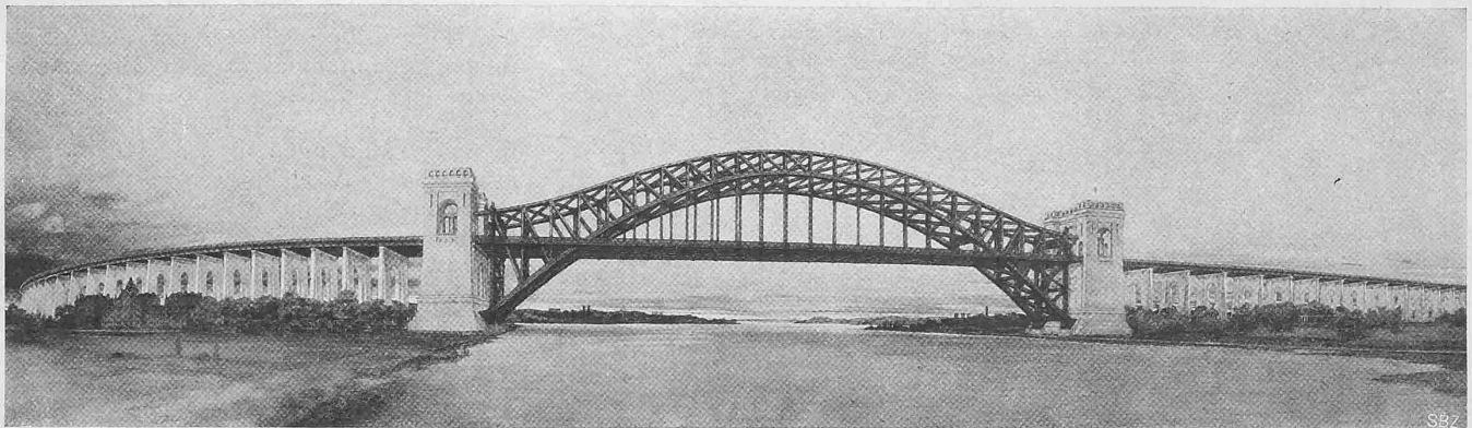
Abb. 1. Gesamtbild der Hell-Gate-Brücke über den East River, flussaufwärts gesehen.
