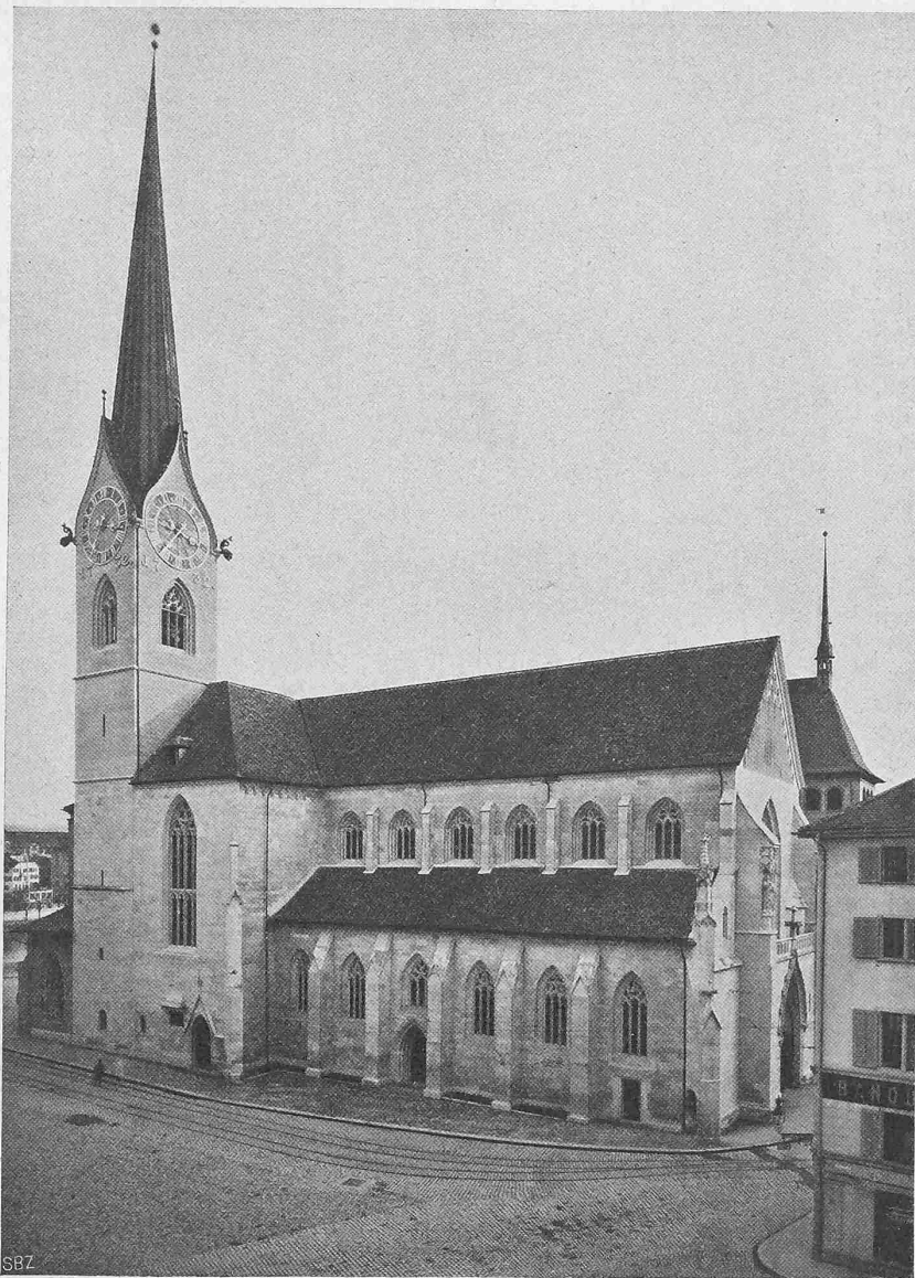
Abb. 6. Ansicht der restaurierten Nordfront, gegen den Münsterhof.
