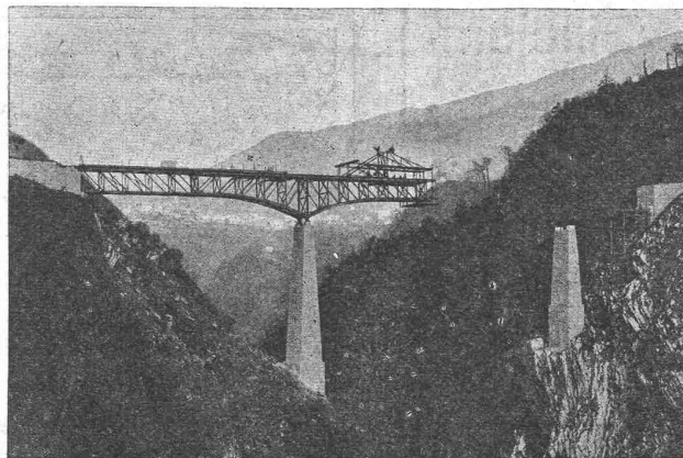
Pont-route sur la Breggia, entre Castello et Morbio-Superiore (Tessin), construit en 1912. Longueur 110 m.
