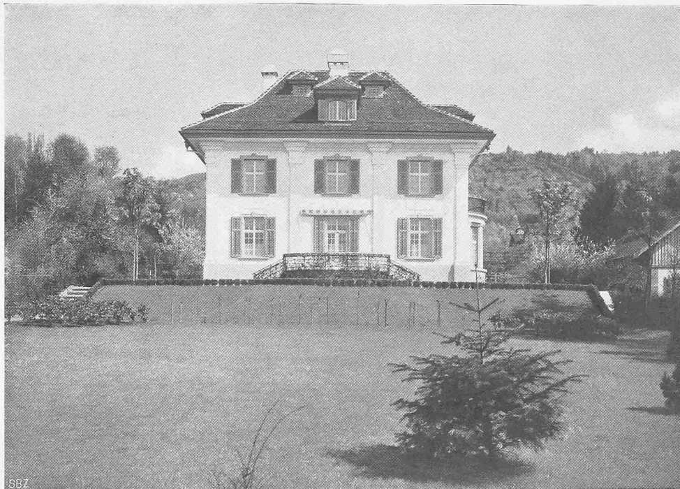
WOHNHAUS „IM VOGELSANG“ BEI ZUG ARCHITEKTEN KEISER & BRACHER, ZUG
