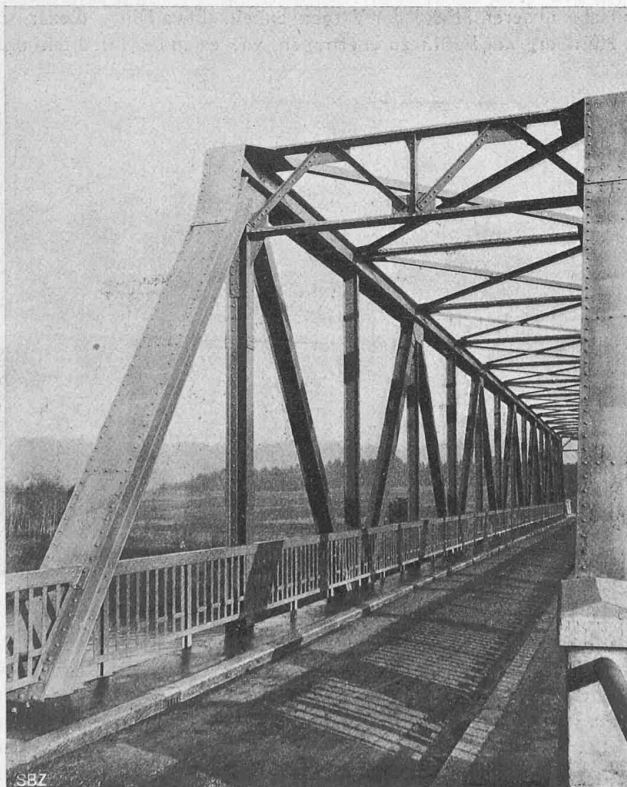
Abb. 3. Einblick in die neue Brücke.
