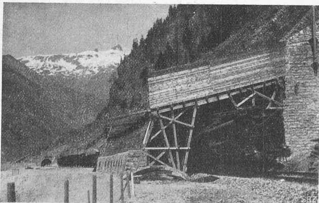
Abb. 34. Prov. Holzgalerie im Stockgraben-Lawinezug.
