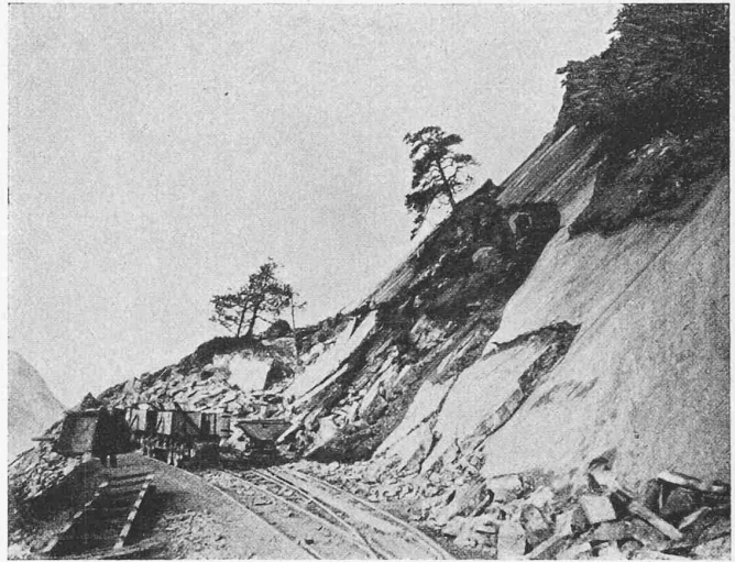
Abb. 23. Felsrutschung bei Hohtenn, am 7. Januar 1913.
