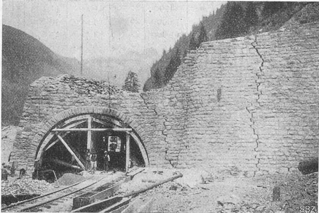
Abb. 31. Stockgraben-Galerie, Portal Seite Brig Ende 1911.
