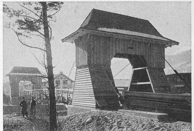
Abb. 6. Portal am rechten Ufer; Spannschlösser.
