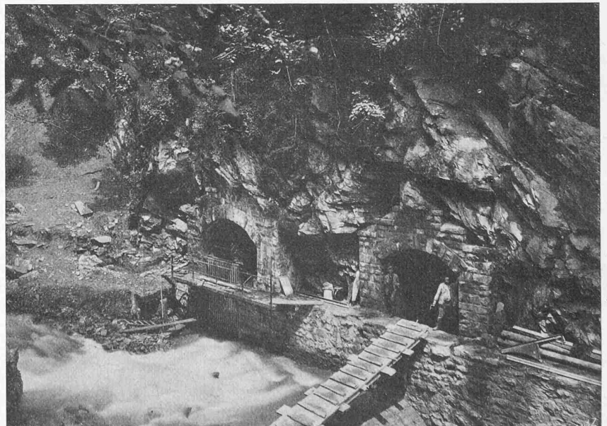
Abb. 14. Wasserfassung der Tine bei deren Kreuzung durch den Hauptstollen (im Bau).
