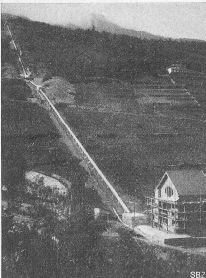
Abb. 17. Druckleitung und Maschinenhaus.
