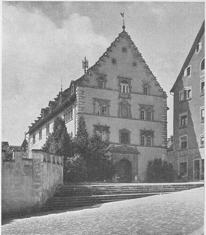
Abb. 2. Ansicht der alten Kaserne, aus Nord-Ost.
