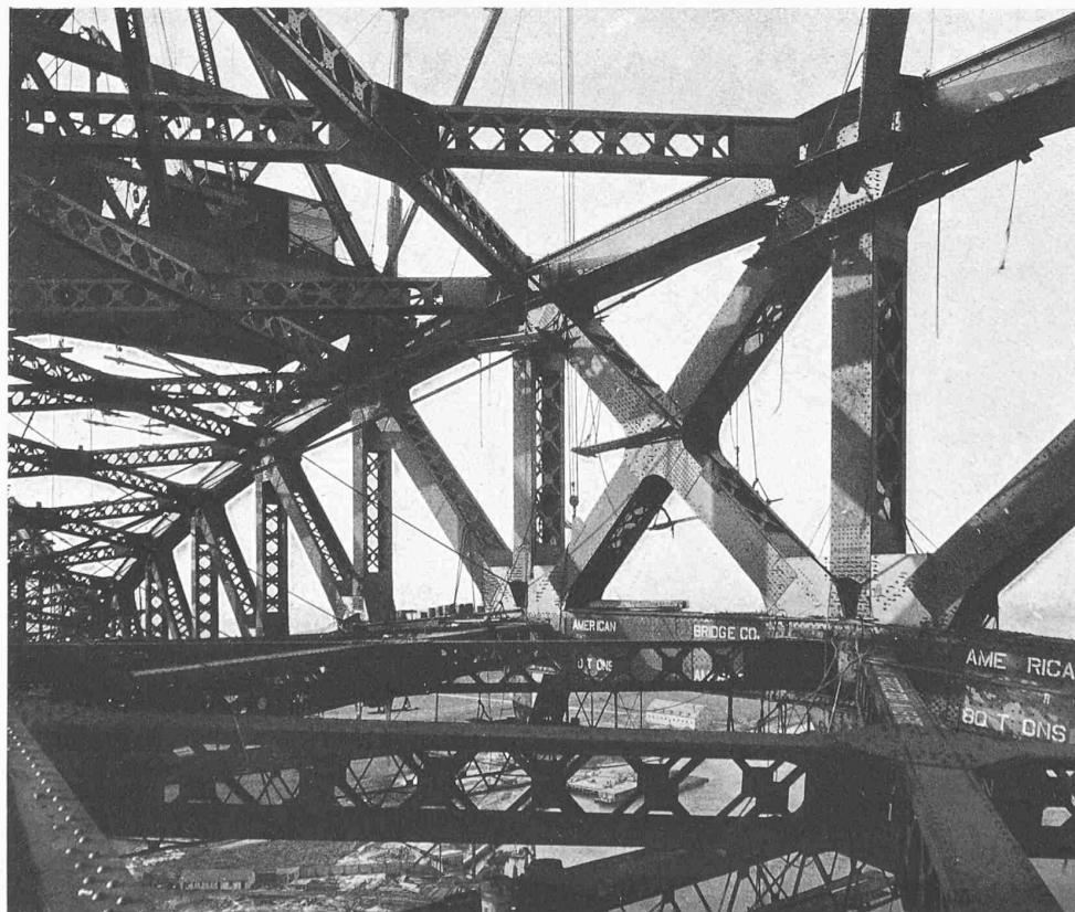
Abb. 18. Blick in das Brückenninnere am Bogenscheitel; Knotenpunkte vernietet.
