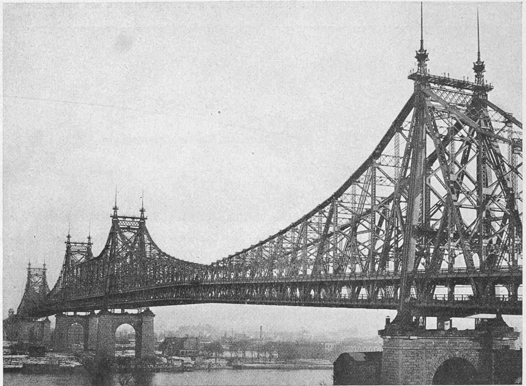
Abb. 14. Queensborough-Brücke in New York, eröffnet 1909, Hauptöffnungen 360 m.
