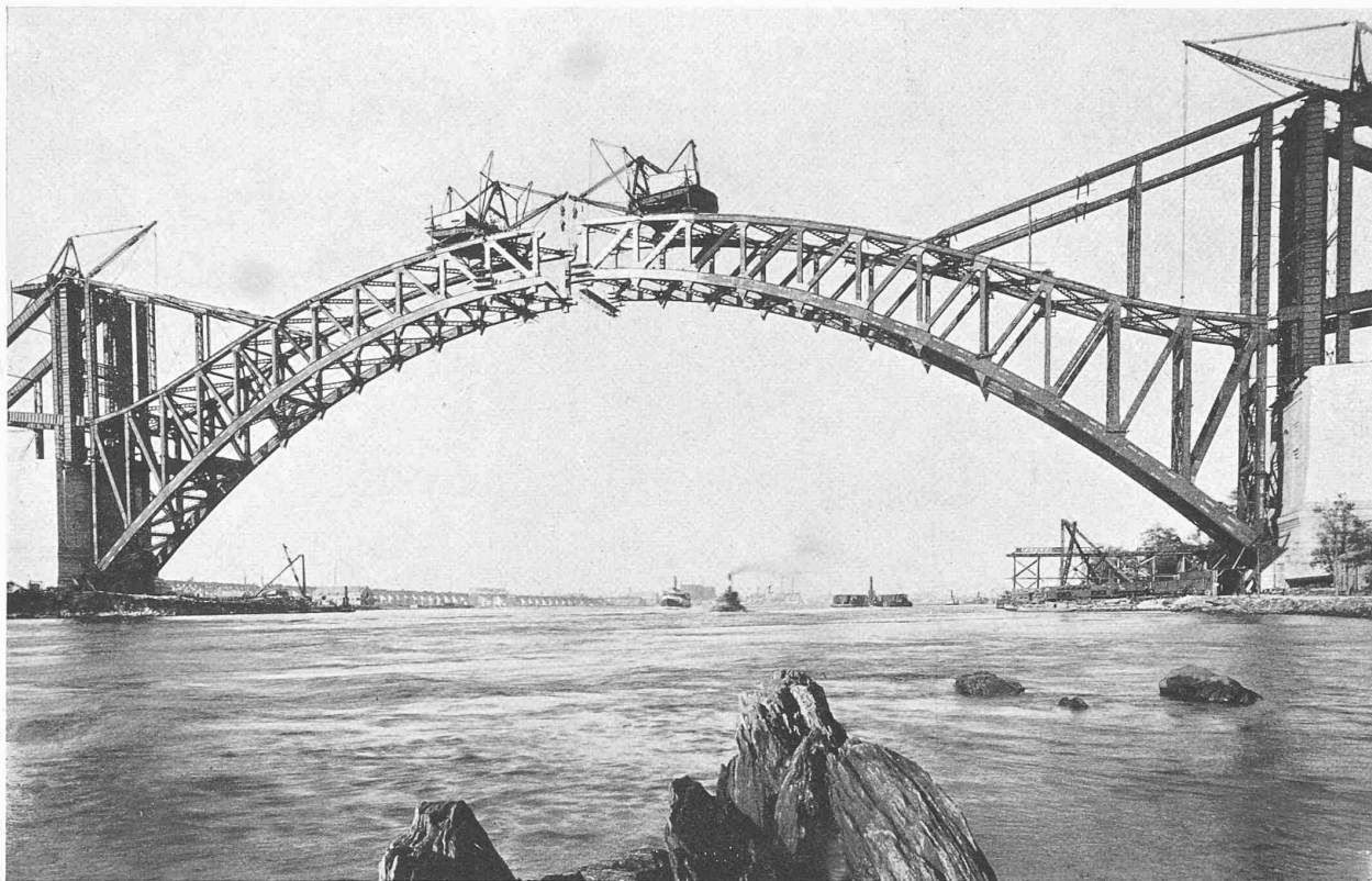
Abb. 17. Am 29. September 1915, unmittelbar vor Bogenschluss.
