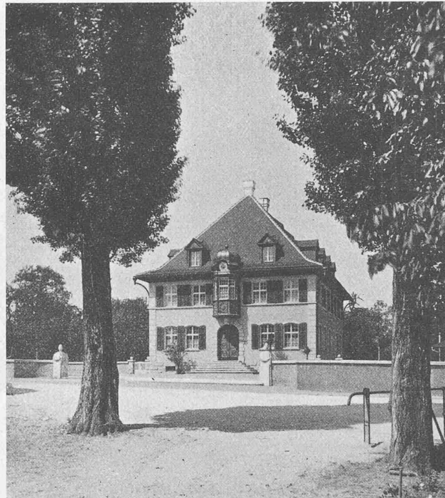
Abb. 5. Ansicht aus Nordost.
