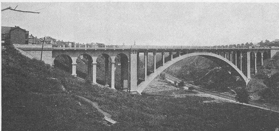
Abb. 37. Larimer Avenue-Brücke in Pittsburgh. — Eisenbetonbogen von 91,5 m lichter Weite.
