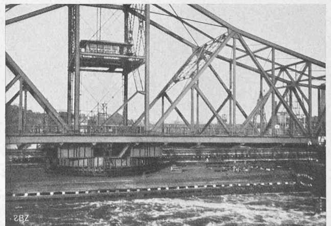
Abb. 38. Drehbrücke auf Rollenkranz im Hafen zu Boston.
