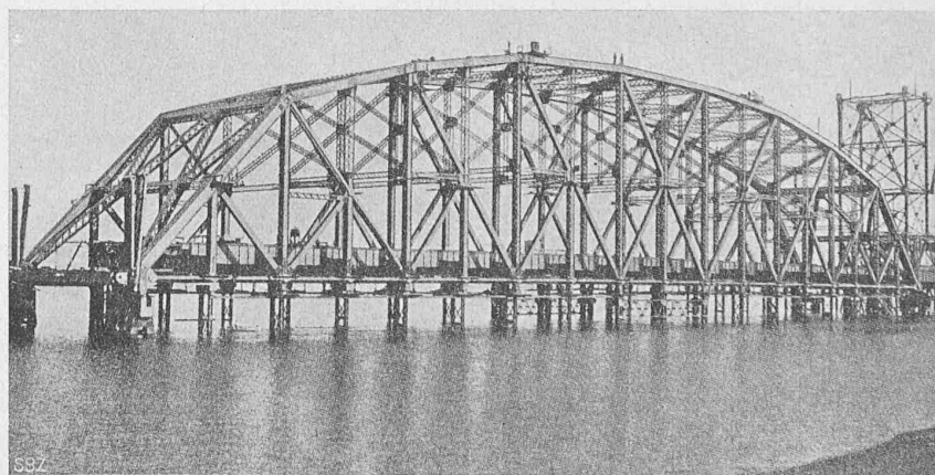
Einhängender Mittelträger der Quebec-Brücke, auf dem Montagegerüst (Nach „Eng. News“ v. 24. Aug. 1916).
