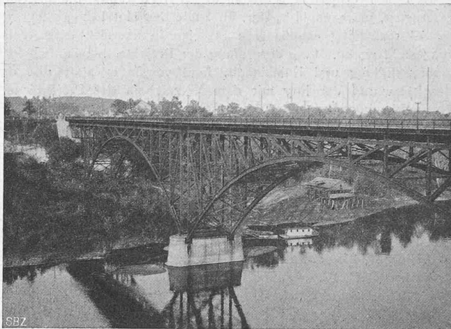
Abb. 63. Fort Snelling-Brücke, Spannweite 2 \times 111 m, über den Mississippi bei San Paul (Minn.).
