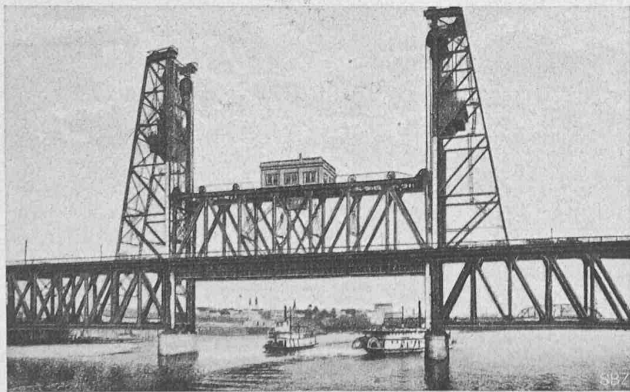
Abb. 53. Hubbrücke über den Willamette in Portland in halb geöffneter Stellung.
